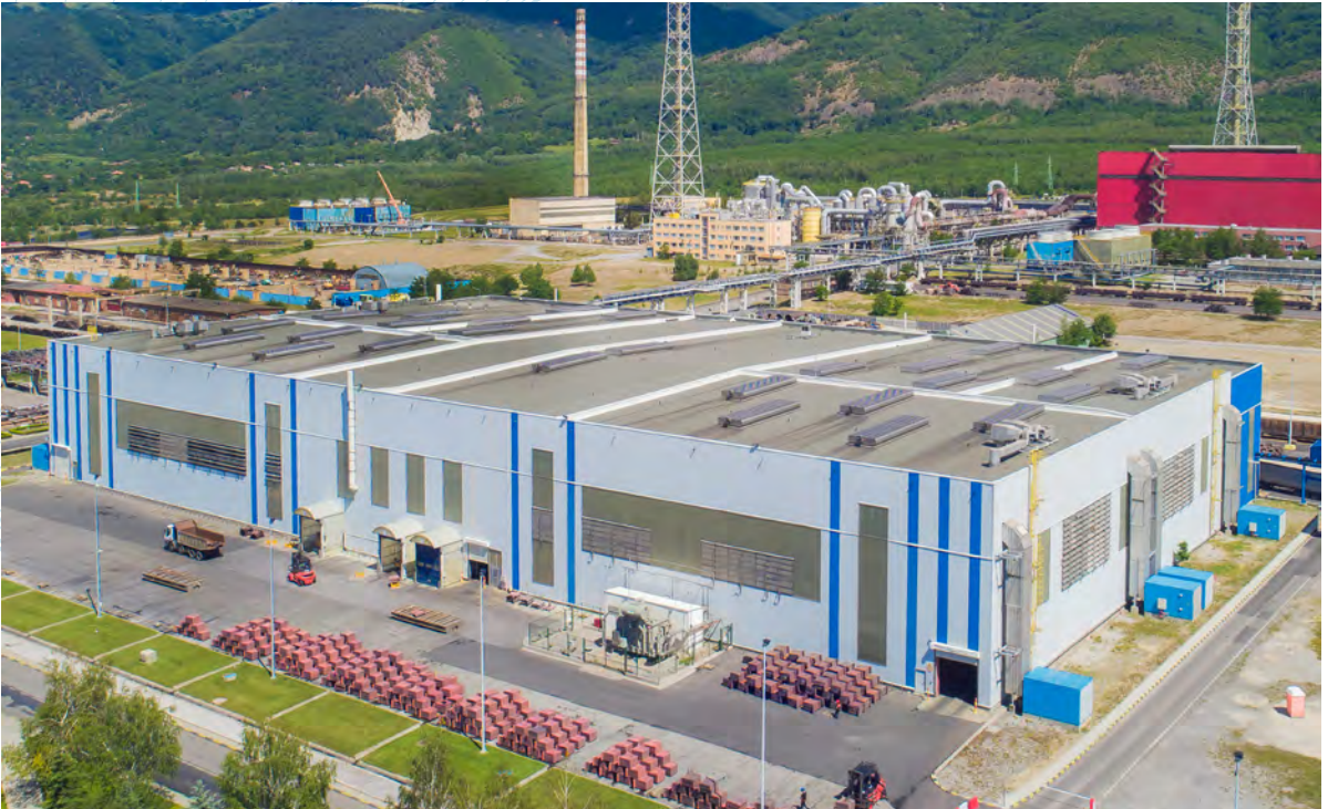
Elektrolyse Pirdop: Ausbau für mehr Output.
