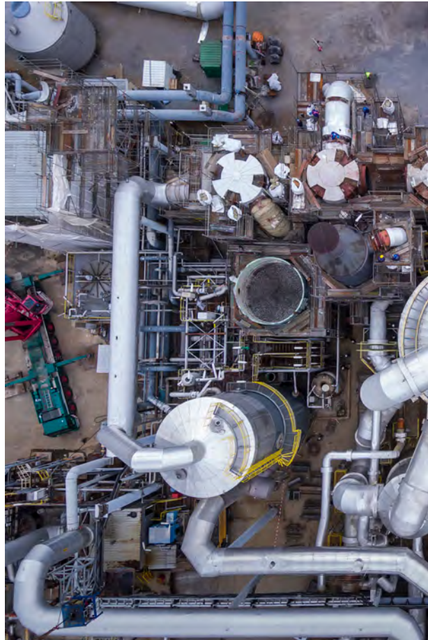
Logistische und technische Meisterleistung: erfolgreicher Wartungsstillstand in Pirdop.
